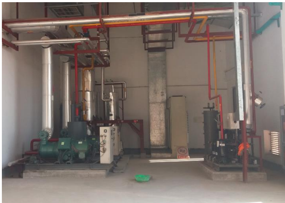
图 3.2-1 制冷机组
