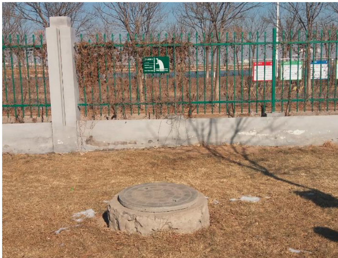
图 4.5-1 污水排放口规范化照片
